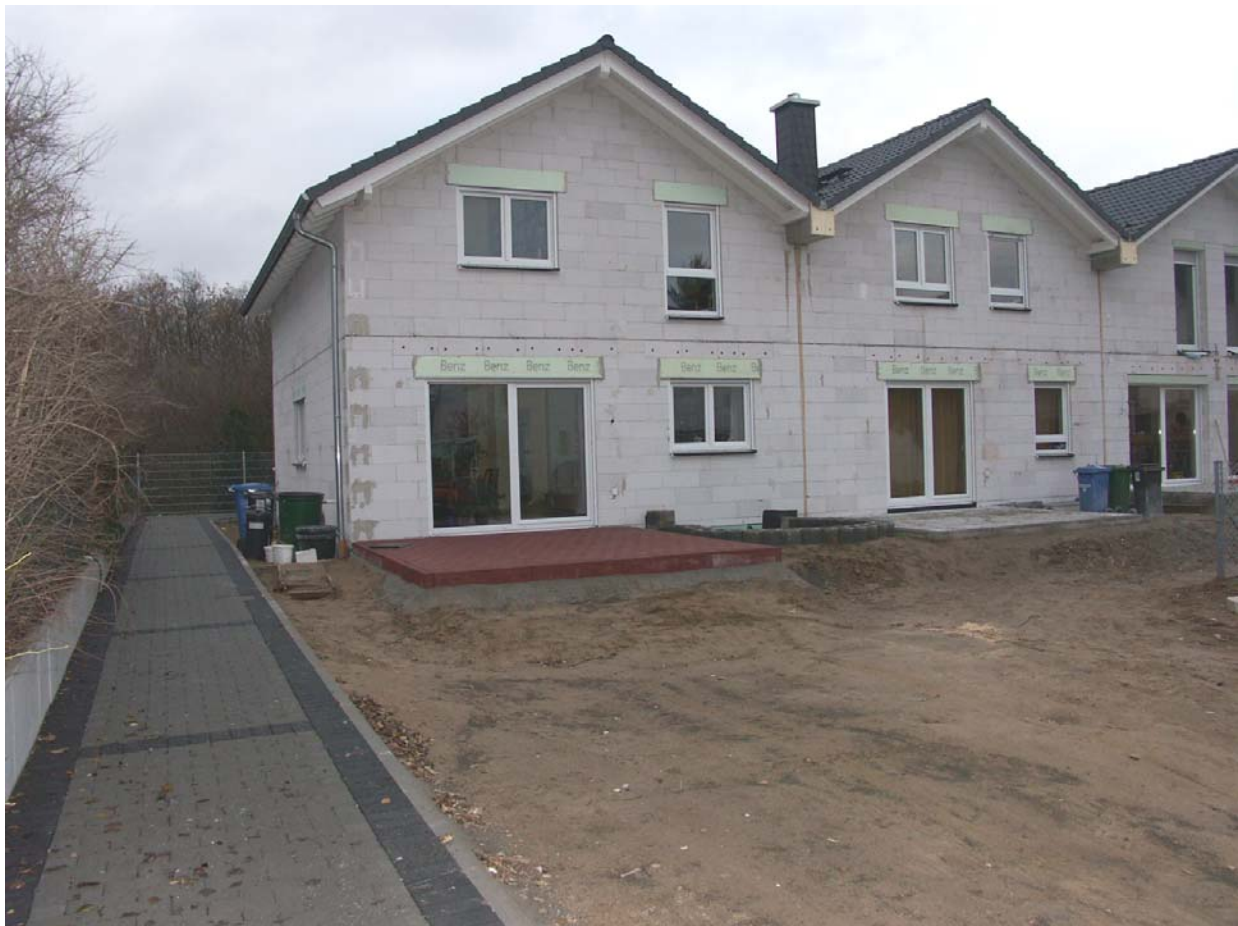
Unser Tagungshaus: Grüner Weg 18 a (b, c), Bauzustand Dezember 2005
