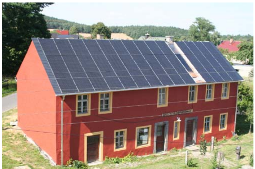
Solarstromanlage auf dem Umwelt- und Naturschutzzentrum in Schwosdorf
